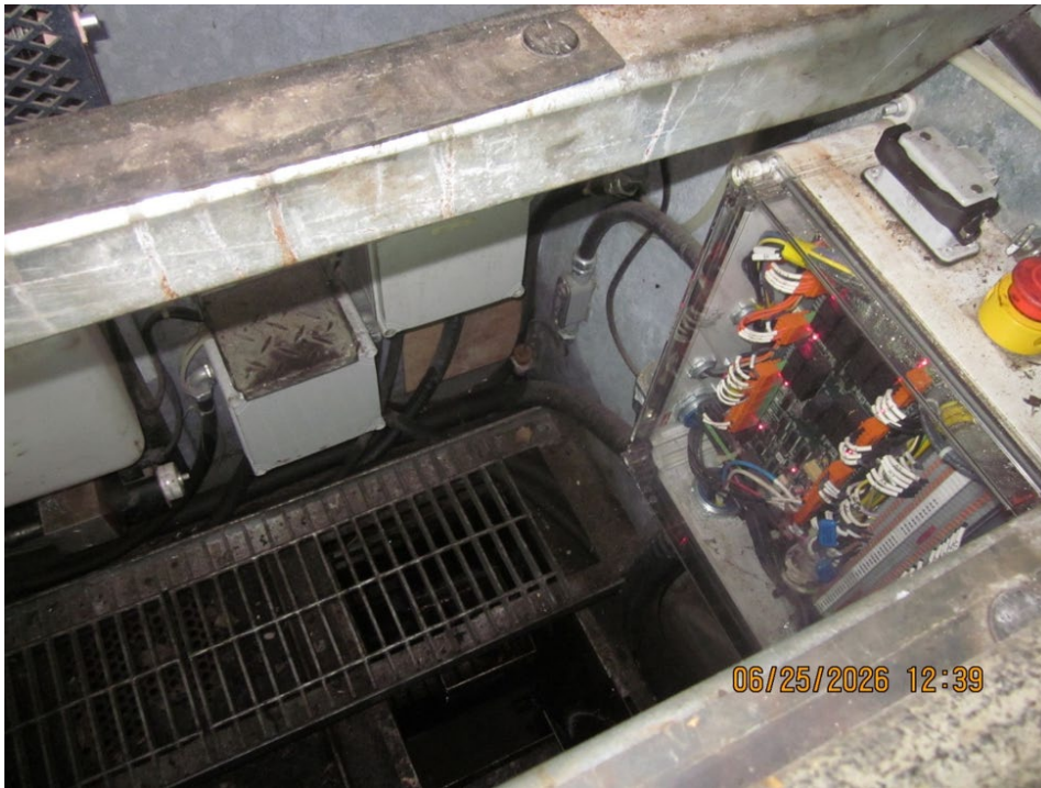
Photo 2: C06X01 escalator pit.
