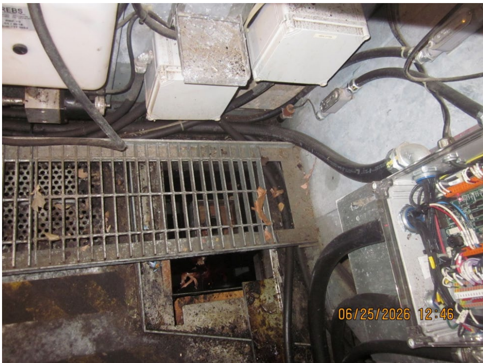
Photo 3: C06X02 escalator pit.
